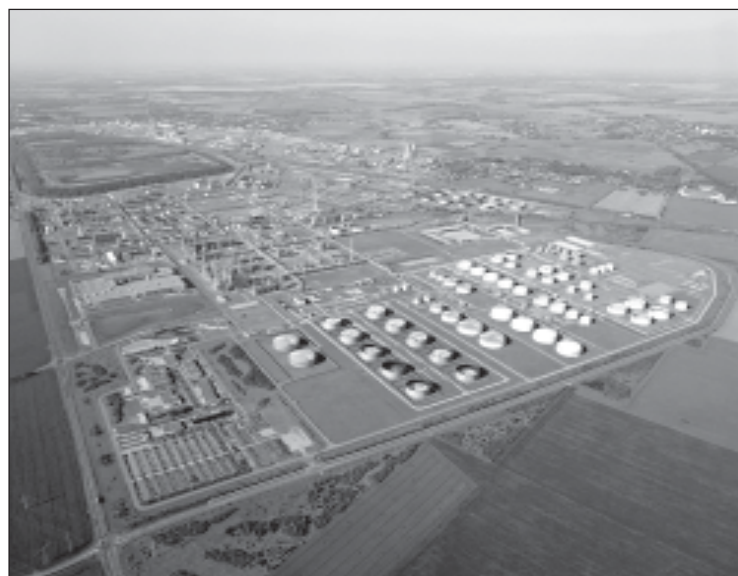
Ein Arbeitsplatz für 9.000 Menschen: Die Leuna-Werke in einer aktuellen Aufnahme aus der Vogelperspektive. Foto: InfraLeuna
